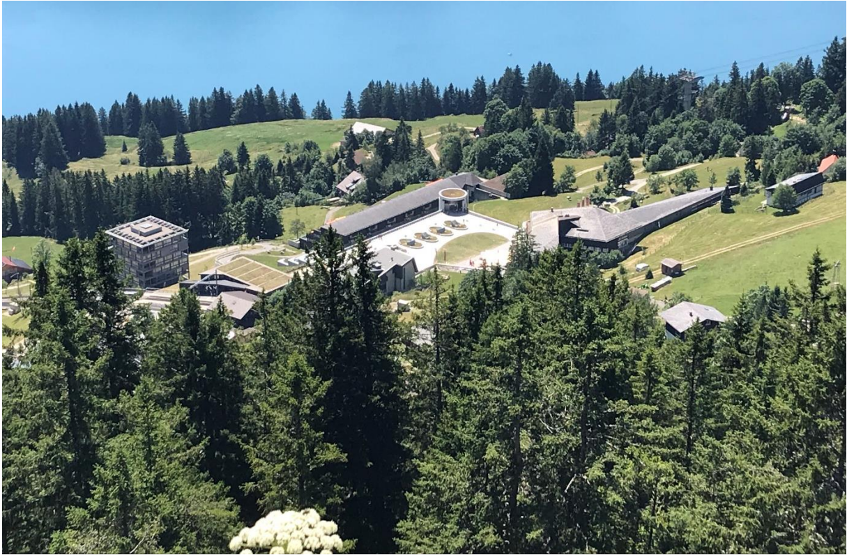
Blick auf den Dorfplatz mit den flankierenden Bauten von Justus Dahinden.
